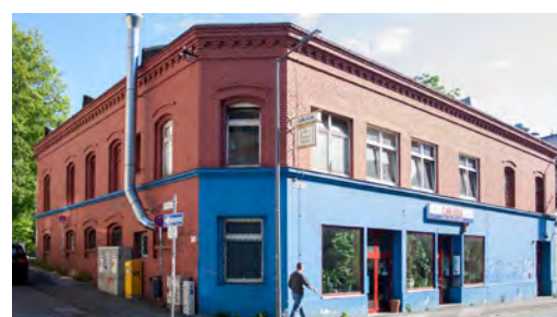
Abb. 3 Baufaufgabe 3: Sanierung und Aufstockung in Wuppertal
