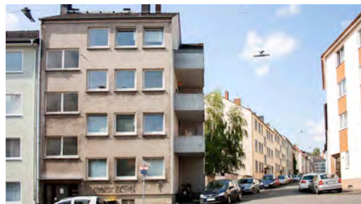
Abb. 1 Baufaufgabe 1: Sanierung und Erweiterung in Wuppertal
