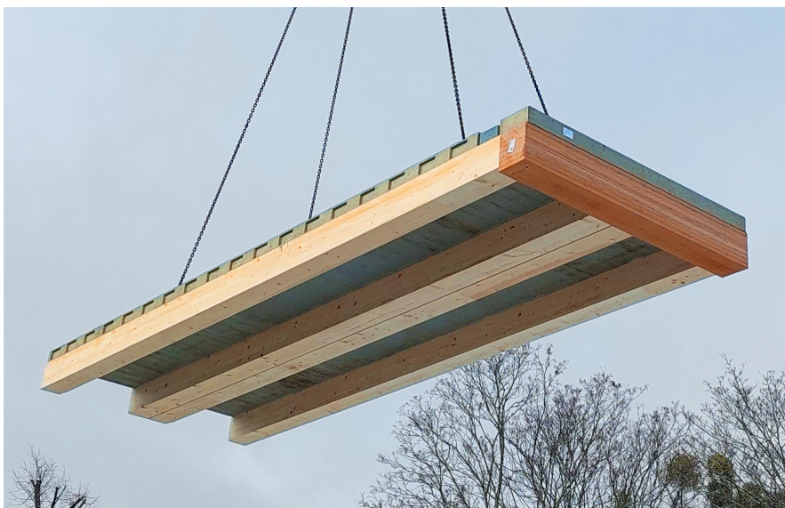
Abbildung 5: Holz-Beton-Verbunddecke mit werkseitigem Aufbeton
