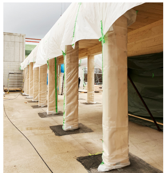
Abbildung 6: Bauteilschutz mittels Folien und Abklebungen
