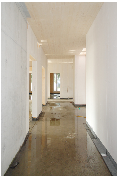
Abbildung 2: Wassereintritt nach einem Regenereignis
