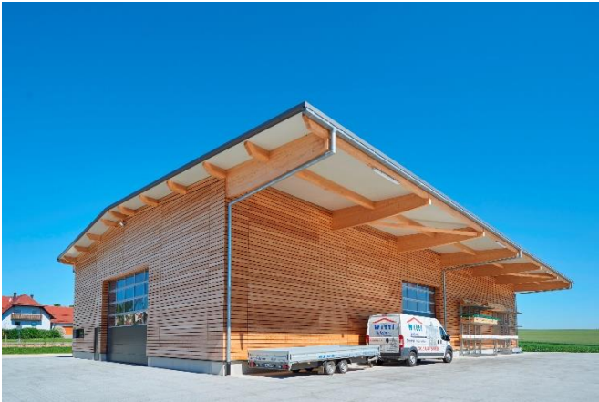
Holzbau Wittl montierte seine Schaffitzel Handwerkerhalle selbst.
