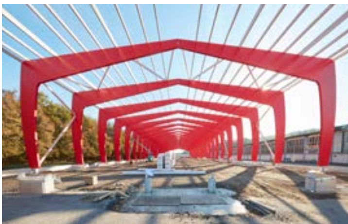
Abb. 7 und 8: Holztragwerk der Produktionshalle
