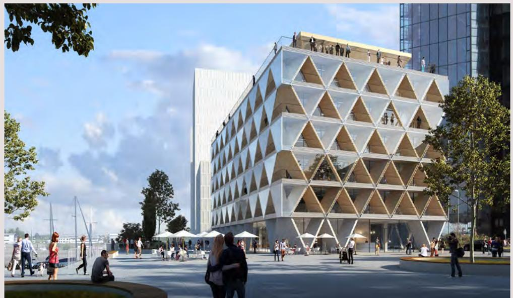
Der Bürobau „The Cradle“ im Düsseldorfer Medienhafen gilt als eines der ersten Gebäude, das im Sinne der Kreislaufwirtschaft „Cradle to Cradle“ (von der Wiege zur Wiege) geplant wurde. Zielvorgabe war, die Bauteile so auszulegen, dass sie nach Nutzungsende bis zu 97 % rückbaubar und wiederverwendbar sind.
